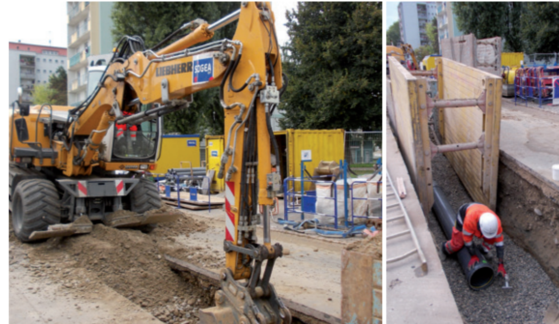
Chantier de la rue Charles Péguy
