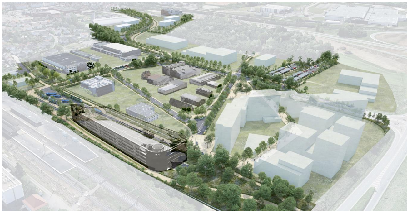
Figure 22 : Perspective présentée à la réunion publique du 8 octobre 2024 (groupement Egis / Bik Architecture Grand Est / Sortons du Bois)
