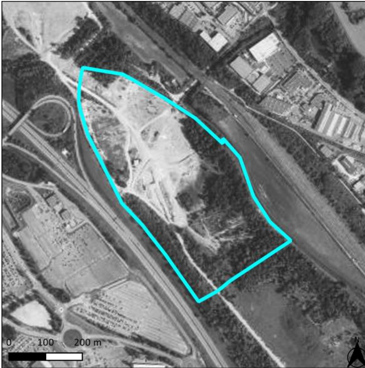
Extension et transformation en ISDI GMR sur l'emprise centrale de l'opération
