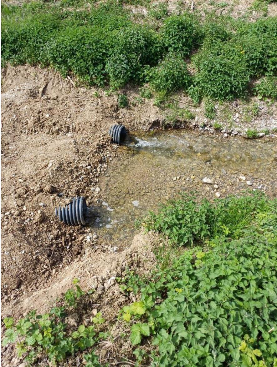
Figure 54 : Busage du Liesbach sur la zone de chantier de l'opération 5A3F – limite Sud du Technoport
