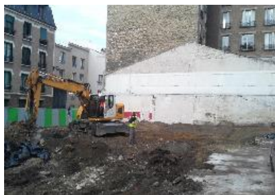
Dépollution et réhabilitation
